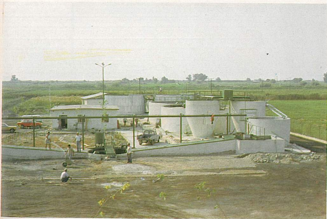
ΥΠΕΡΣΥΓΧΡΟΝΗ ΕΓΚΑΤΑΣΤΑΣΗ ΒΙΟΛΟΓΙΚΟΥ ΚΑΘΑΡΙΣΜΟΥ
